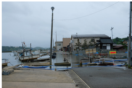
被災した石崎漁港
