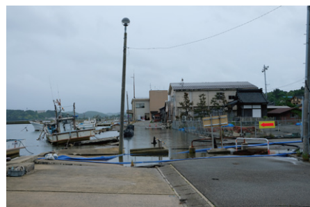
被災した石崎漁港
